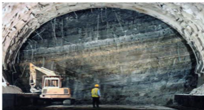
شکل ۱۸-۲- حفر تونل به روش ADECO-RS در تونل راه آهن Tartaguille بین لیون و مارسی در فرانسه
